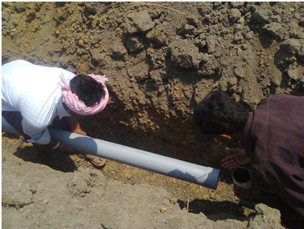
Obr. 5 Výstavba vodovodného potrubia
