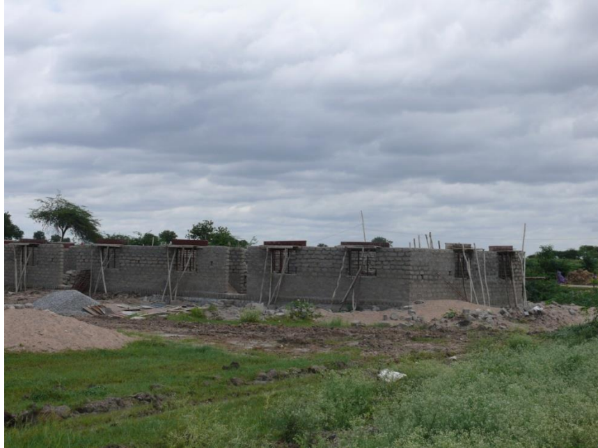
Obr. 1 Výstavba škôlky v obci Jagir Pannur
