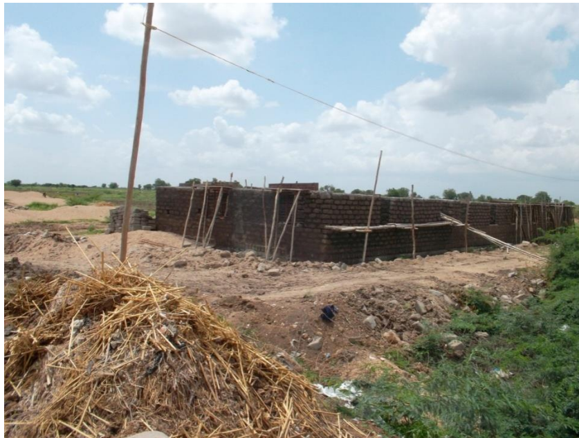
Obr. 2 Výstavba škôlky v obci Jagir Pannu
